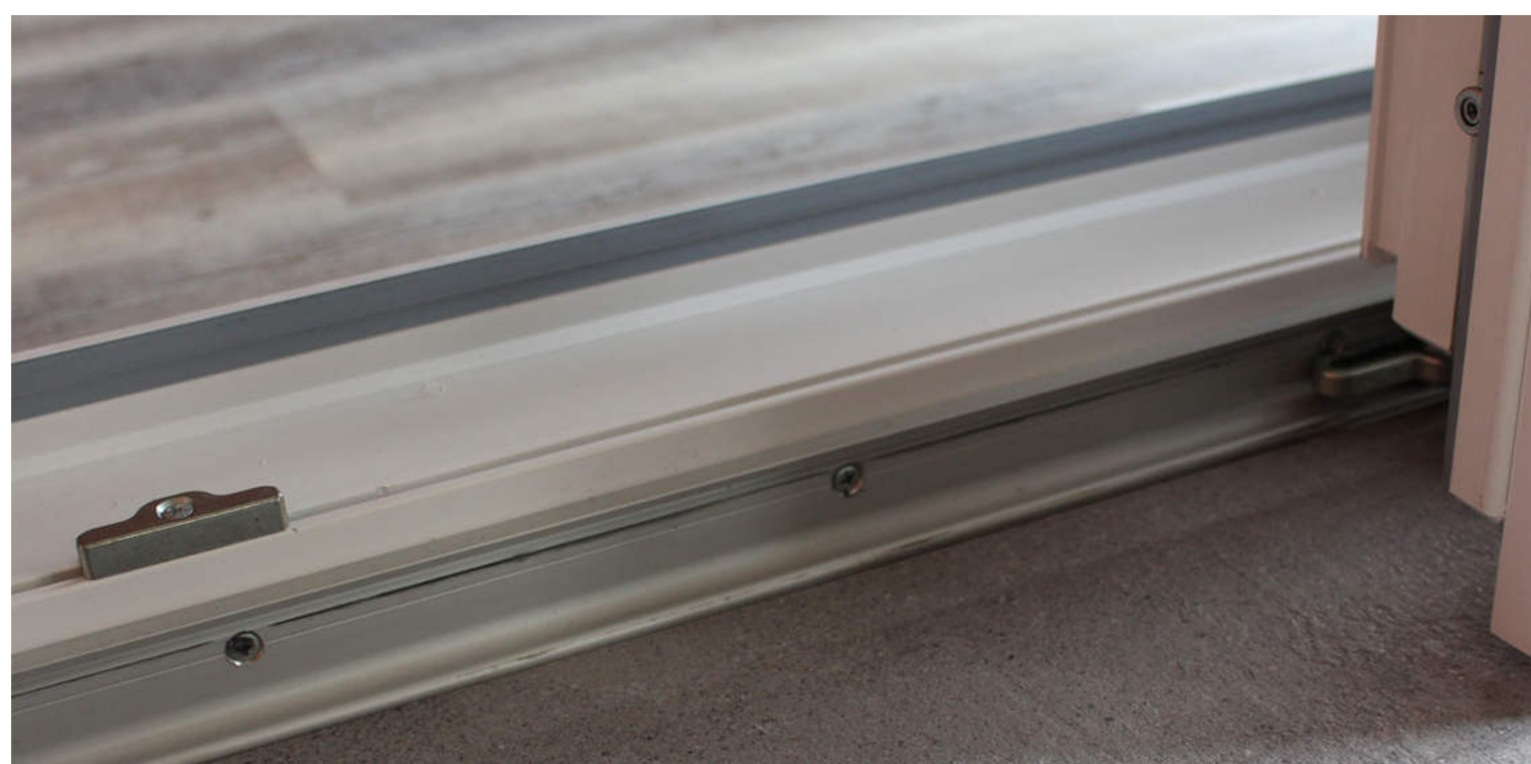
Detailansicht Bodenschwelle Abstell-Schiebetür und PSK-Tür
