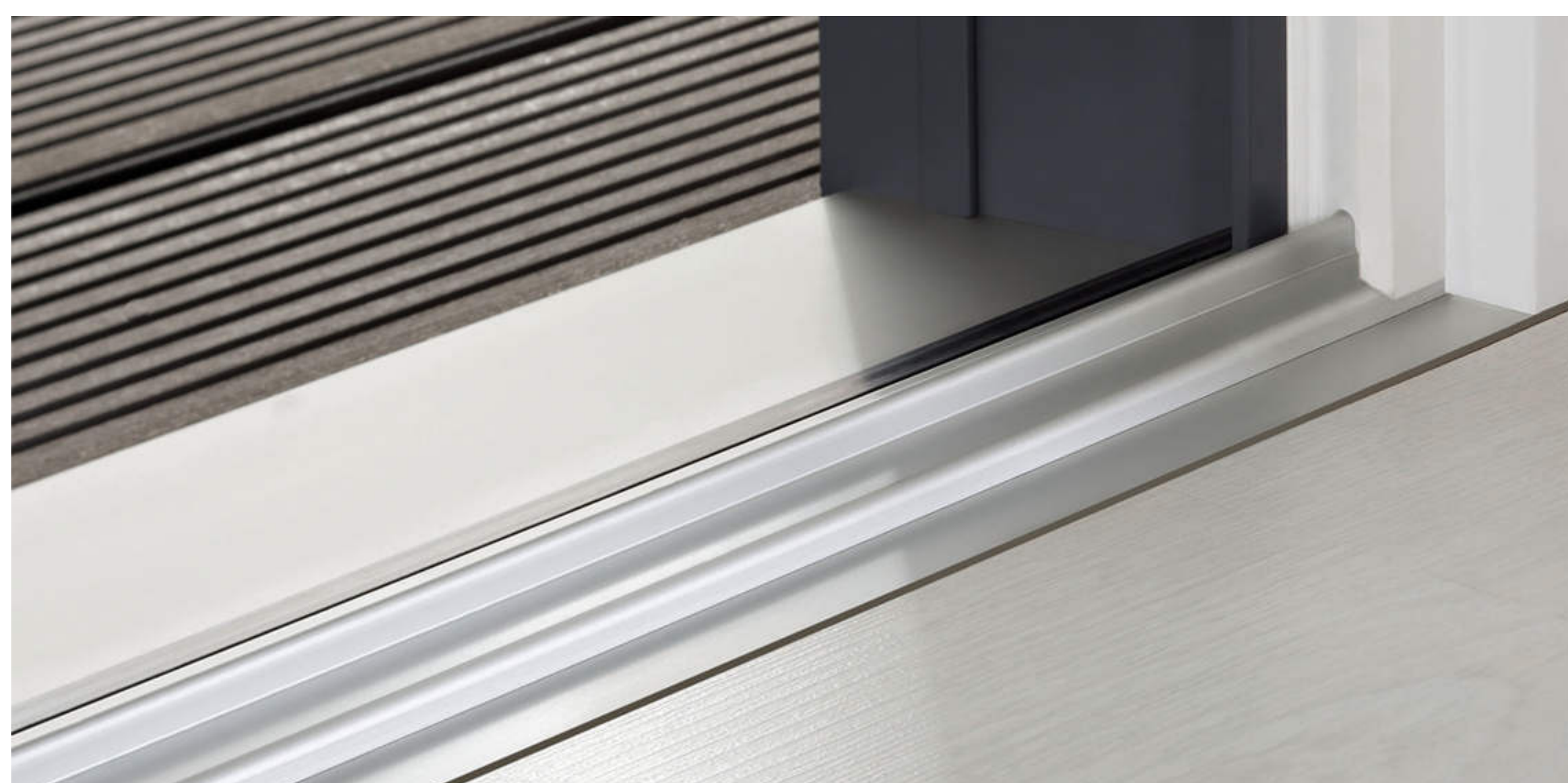
Detailansicht Bodenschwelle Hebe-Schiebetür
